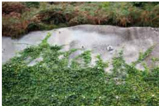
Mendi-mazeletako euste-lanak Elantxoben. Obras de contención en las laderas de Elantxobe.
