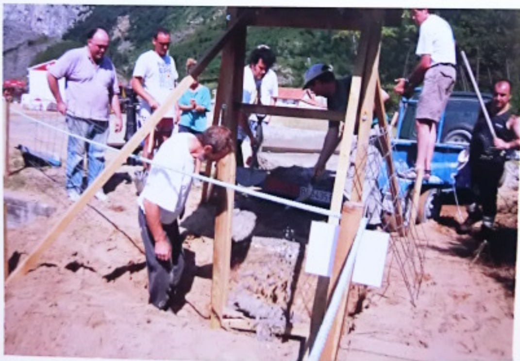
Interpretazio-panelak jartzeko momentu desberdin bi adierazten dira. Goikoan zementua egiten eta behekoan zementu horrekin eta burdinezko mailakin panelen oinarria egiten.
