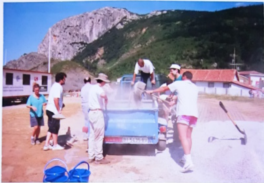
Interpretazio-panelak jartzeko momentu desberdin bi adierazten dira. Goikoan zementua egiten eta behekoan zementu horrekin eta burdinezko mailakin panelen oinarria egiten.
