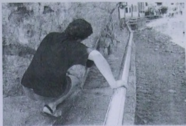
POLÉMICA. Un joven se apoya en una tubería que trasladará fangos. ¿estará bien?
