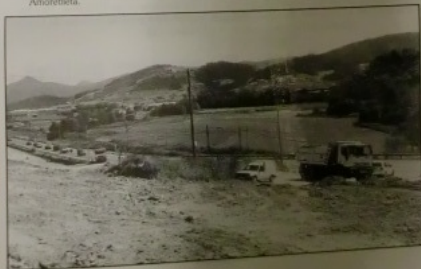
El Viaducto de Arana, que marca el punto de inicio, salvará la carretera Amorebieta-Gernika y el Ferrocarril (Foto Angel Grande).
